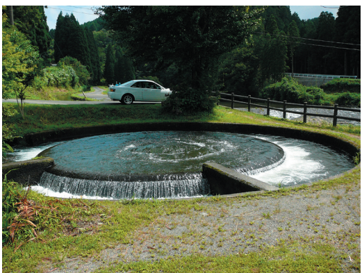
通潤橋への分水を行う笹原川沿いの円形分水工。仕切りで三二七〇度…一（九〇度）に分けられ、「三」が通潤橋へ送られる。 本人撮影 二〇〇九年八月
